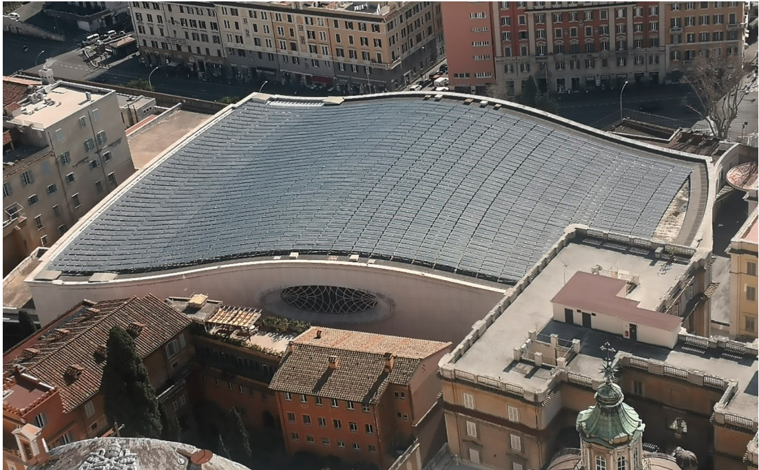
Figura 2. Pabellón Nervi en Ciudad del Vaticano convertido en centro de producción de energía solar. Fuente: Antonio Antequera
